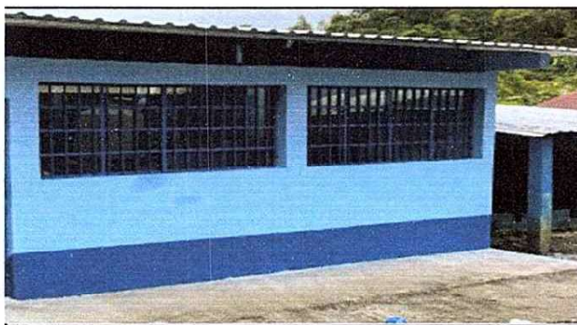
Foto 4: Instalación de ventana-balcón.
