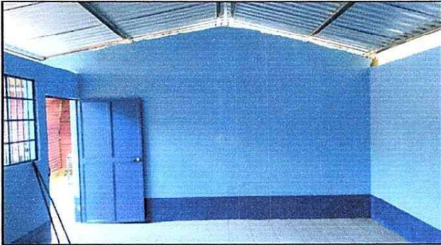
Foto 7: pintura interior establecimiento.
