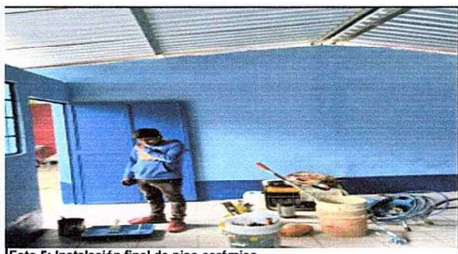
Foto 5: Instalación final de piso cerámico.
