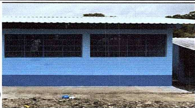
Foto1: levantamiento formal de paredes.
